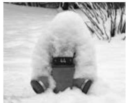
Hydranten müssen bei Ernstfällen schnell zugänglich sein. (Bild: zVg)
